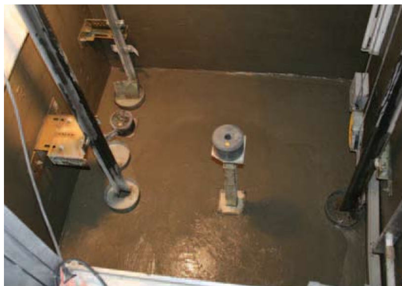
Hisschakt före och efter.
