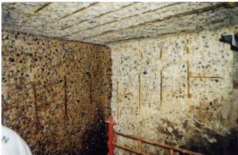
Pumpgrop – renoverad och ytskyddad.
